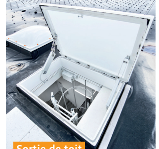
Sortie de toit
