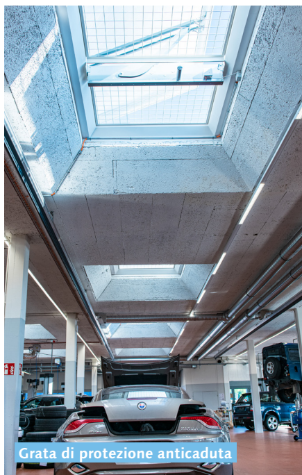
Rete anticaduta in CNS easy-fix
