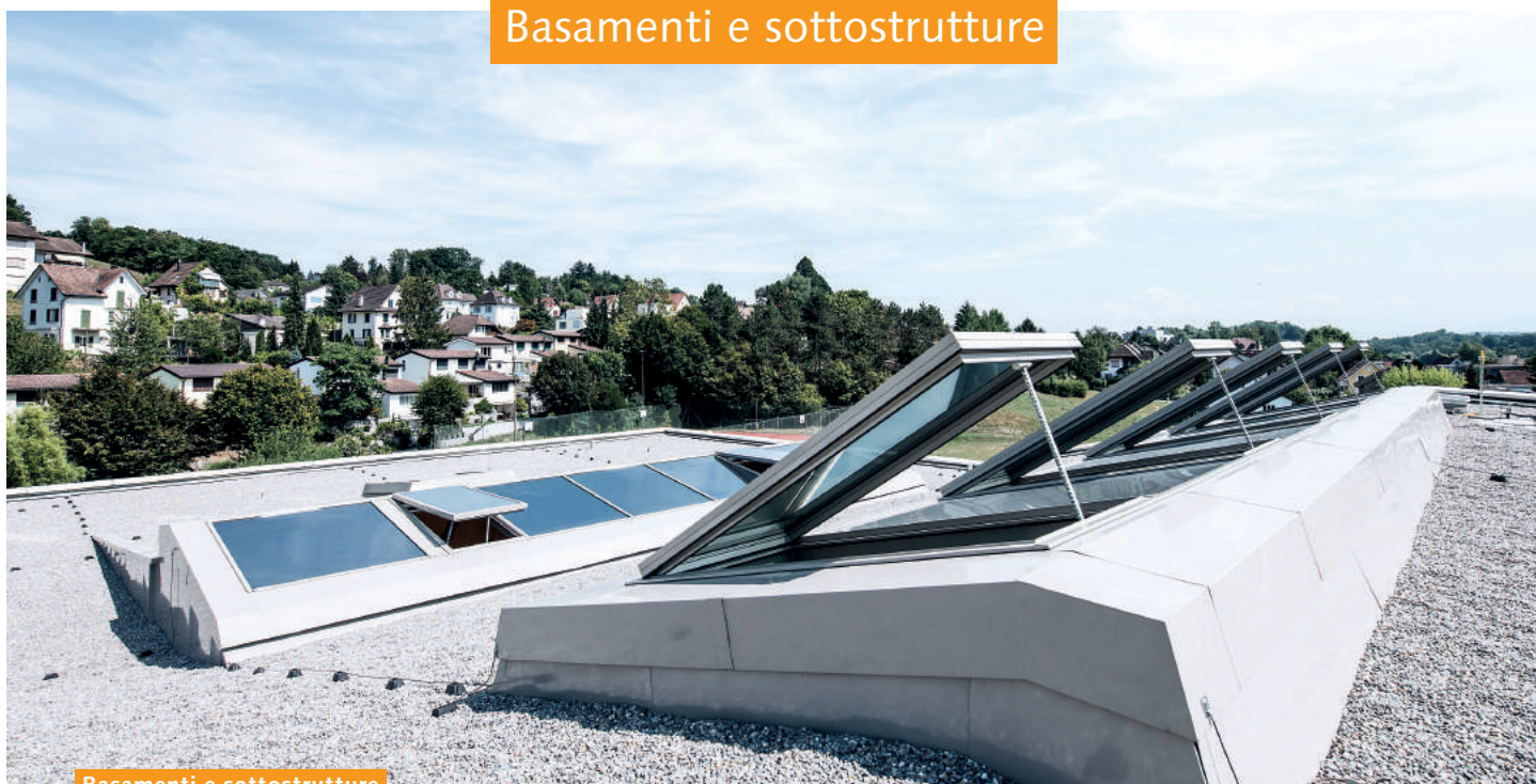
Basamenti e sottostrutture
